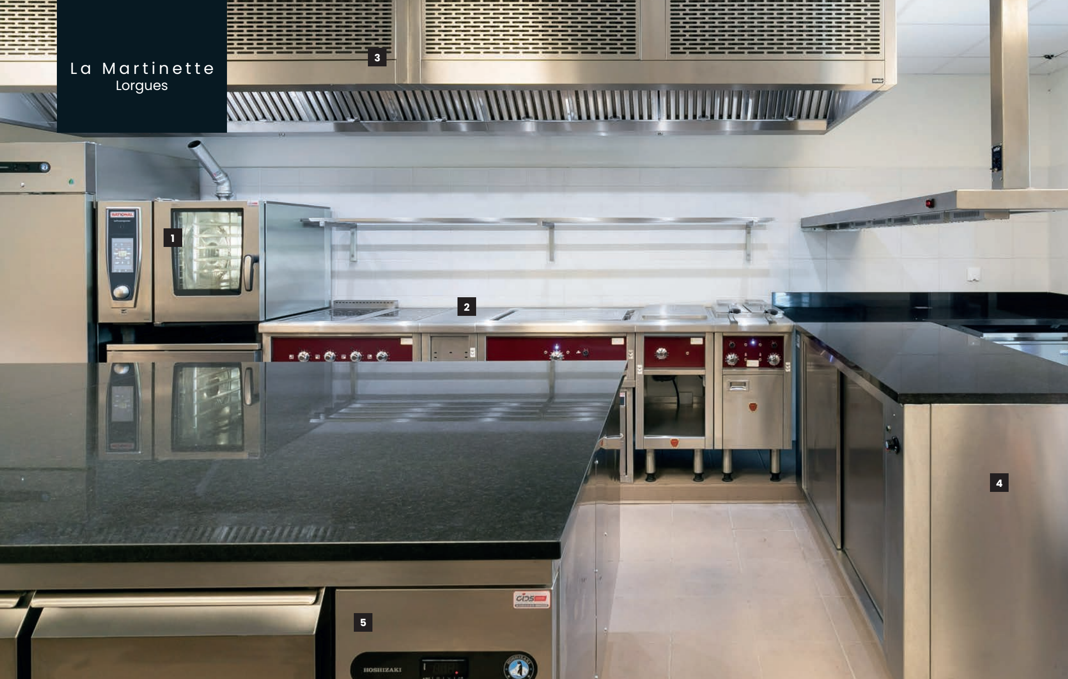
1 Four mixte RATIONAL 2 Ensemble cuisson CHARVET 3 Plafond filtrant SAFTAIR 4 Inox sur mesure GASTROPOLAND 5 Meuble réfrigéré HOSHIZAKI
