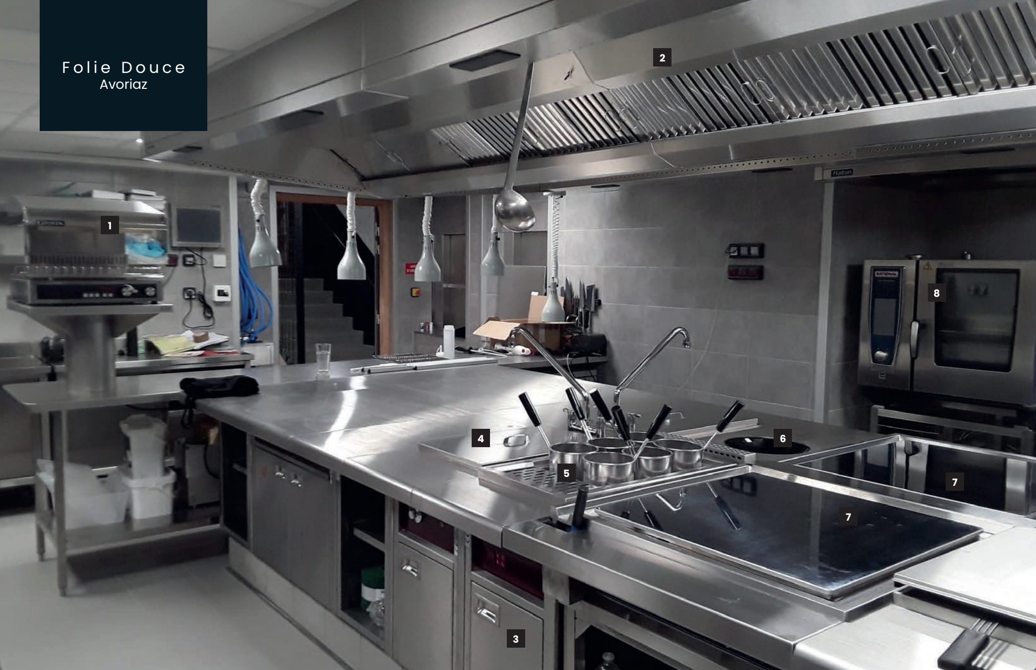
1 Salamandre GIORIK 2 Plafond mobile 3 foyers 3 Etuve CHARVET 4 Bain-marie CHARVET (x2) 5 Cuiseur à pâtes CHARVET 6 Wok CHARVET 7 Plancha chrome Ardox METOS (x2) 8 Four mixte RATIONAL
